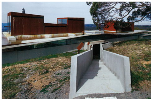
Access on west 西側アプローチ
